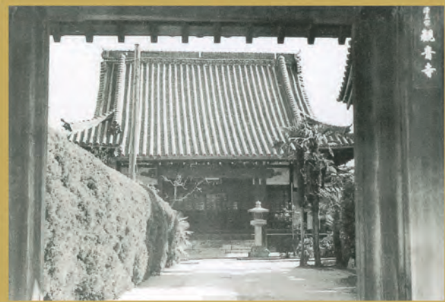
開校当時の仮校舎・吹田観音寺
