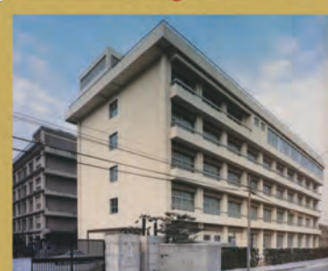
焼失した木造校舎跡に鉄筋 5 階建ての高校南館を建設
